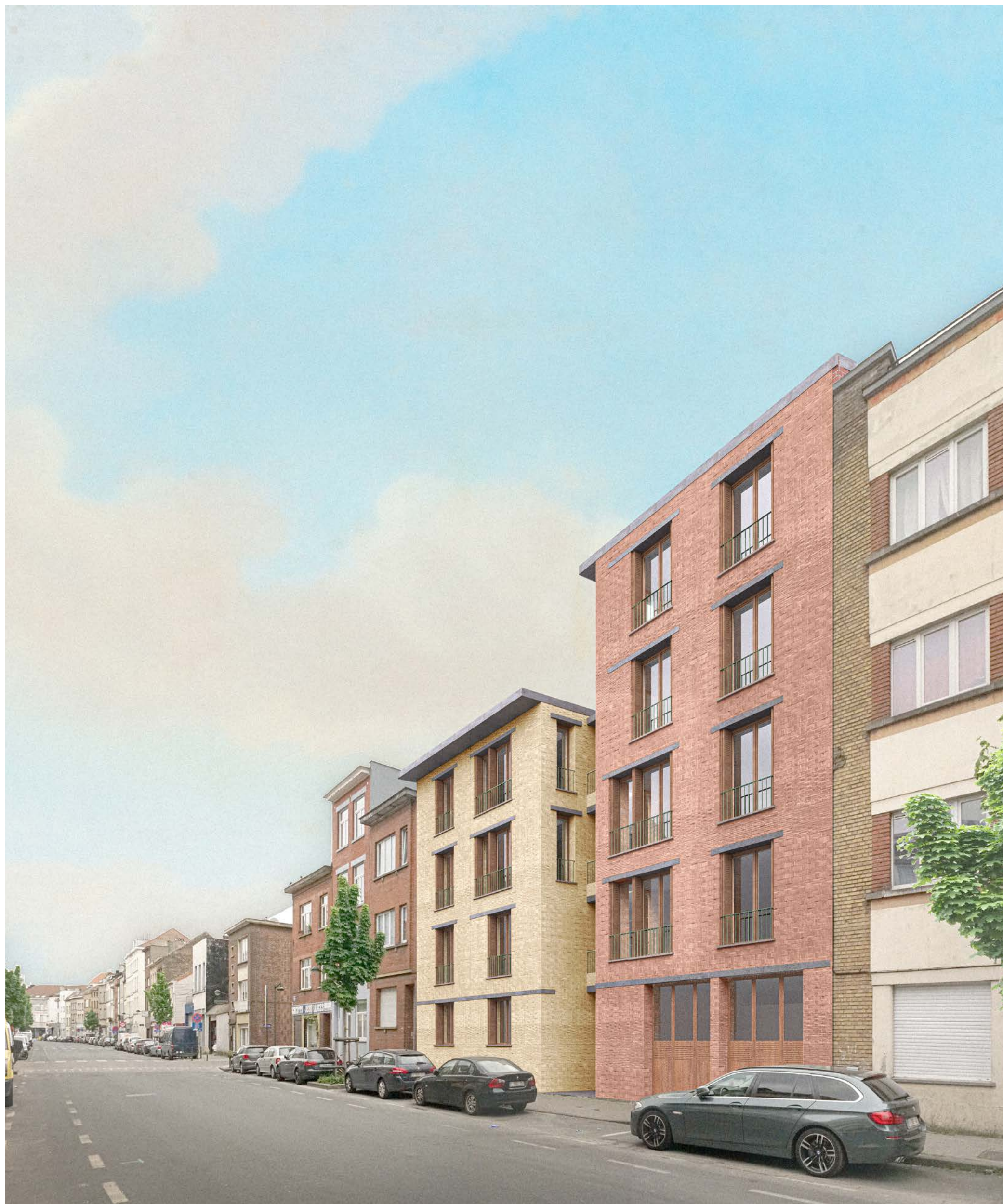
Vue depuis la chaussée d'Anvers.
